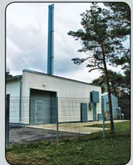
Таллинн, полигон ТБО Когенерационный модуль 1 x JMS 316 Вид топлива: свалочный газ Электрическая мощность – 830 кВт Тепловая мощность – 1010 кВт Электрический КПД – 38, 81 % Общий КПД – 80, 35 %
